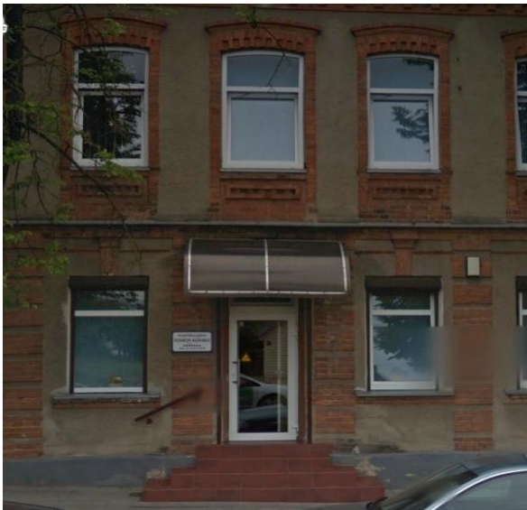
16 pav. Nepritaikytas įėjimas neįgaliesiems į šeimos kliniką
