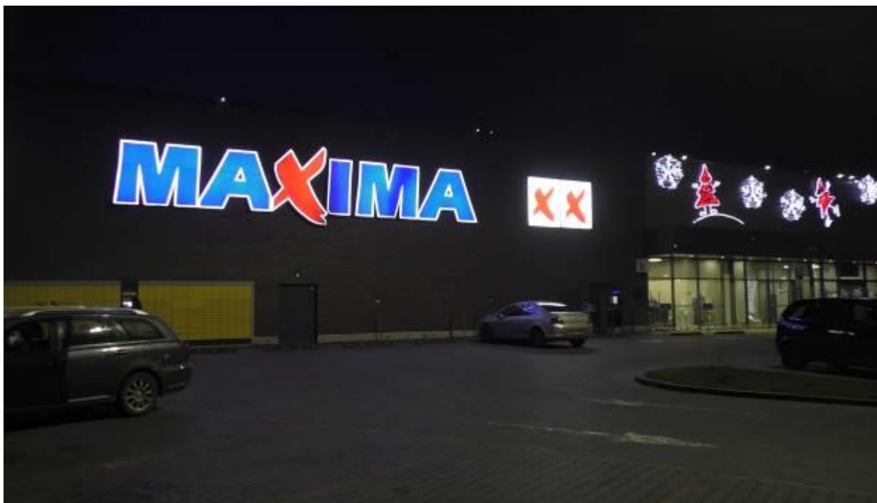
53 pav. Laisvės pr.: Parduotuvės siena neturi jokių vandalizmo požymių. Vandalai nedrįsta niokoti parduotuvės pastato, nes žino, kad jis yra prižiūrimas ir stebimas.
