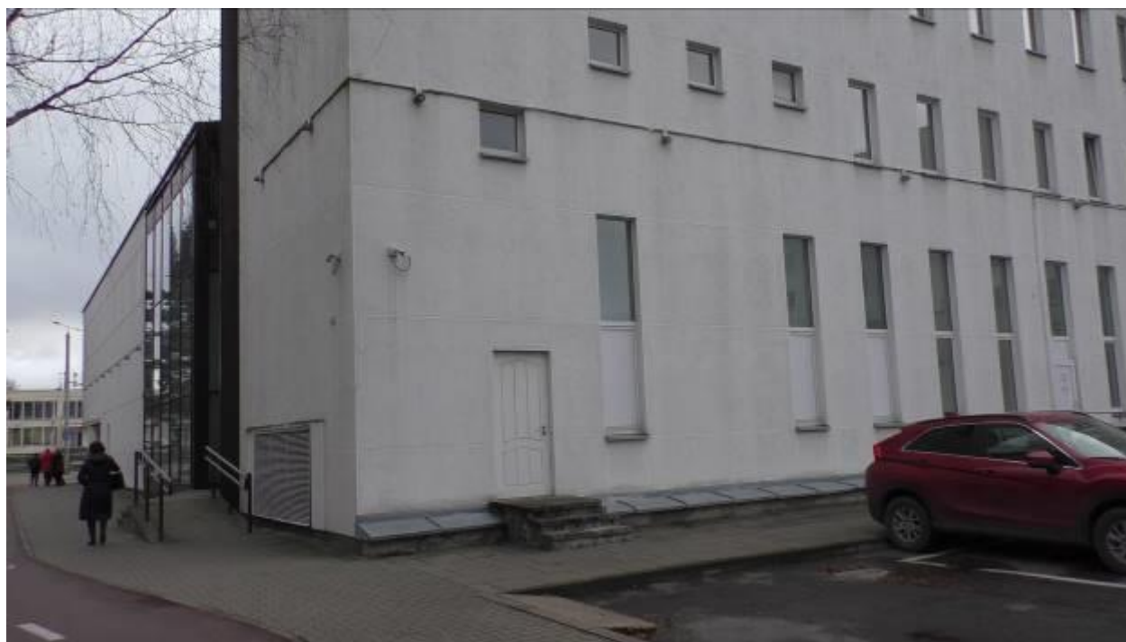
54 pav. Laisvės pr.: „Sodros“ pastatas. Tai buvo vienas pirmųjų statinių Karoliniškėse po nepriklausomybės atkūrimo. Ant abiejų kampų stovi vaizdo stebėjimo kameros. Kaip galima pastebėti, pastato apšvietimas buvo įrengtas jau po to, kai objektas buvo pastatytas. Šių papildomų išlaidų būtų galima išvengti, jeigu projektavime dalyvautų NPPAD specialistas.
